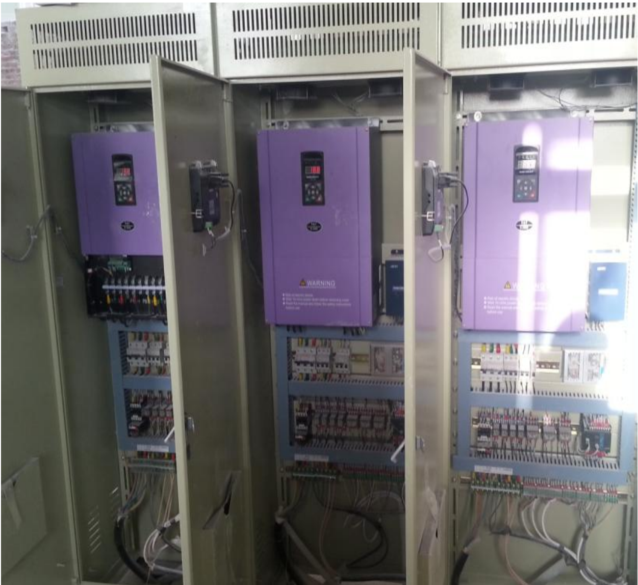
图为 B3000-4T0370G 变频器与 PLC,触摸屏的通讯控制
